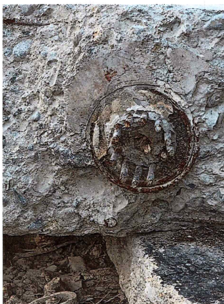
IMAGEN 35: ACERO DE CABLES DE VIGAS POSTENSADAS
