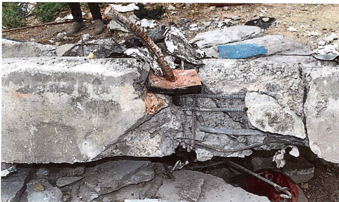
IMAGEN 22: ANCLAJE DE VIGA TRANSVERSAL A LA VIGA PERIMETRAL
