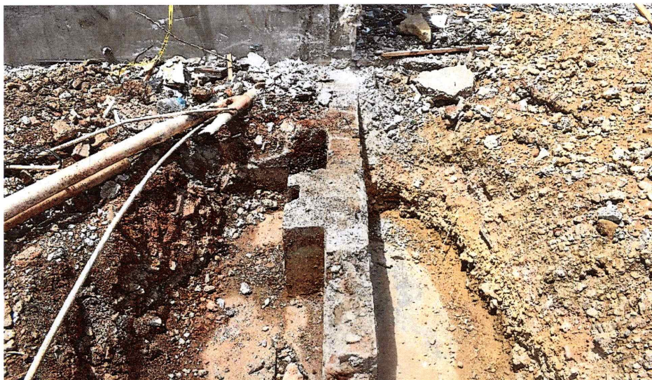
IMAGEN 27: ZAPATA DE LA COLUMNA ELIMINADA EN ESCENARIO.
